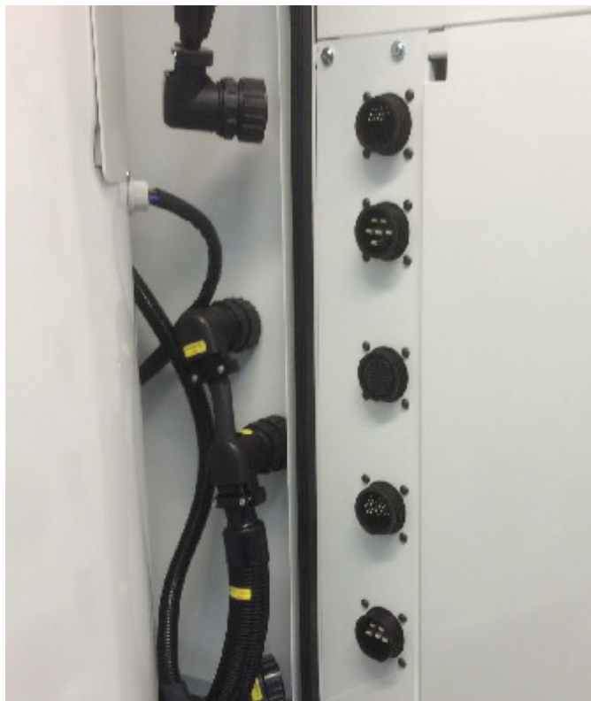
Bildet viser avmonterte bajonettkoblinger
